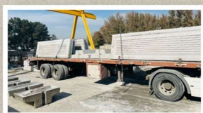
بارگیری قطعات پیش ساخته
