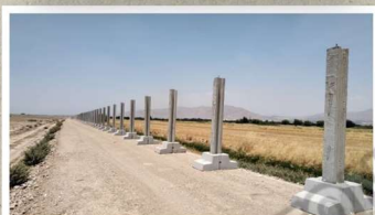
نصب ستون و فونداسیون ورکلاژ
