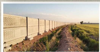
توانایی نصب روزانه هر اکیپ نصب ۳۰۰ متر مربع
